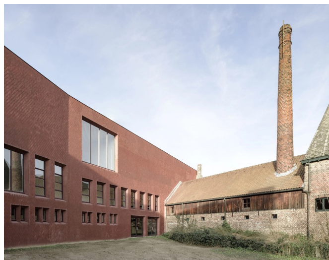
EXEMPEL PÅ MUSEUM SOM GENOM EN SAMTIDA TOLKNING BYGGER VIDARE PÅ LOKAL HISTORIA. Z33 RITAD AV FRANCESCA TORZO. FOTO: GION BALTHASAR VON ALBERTINI
